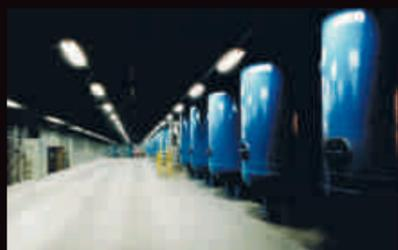
Nos anos 90, a Metalplan venceu duas licitações para o fornecimento de 600 m<sup>3</sup> em reservatórios de ar comprimido para o rebaixamento das turbinas das UHE's Segredo e Salto Santiago (COPEL). Foram utilizadas mais de 250 toneladas de chapas (aço classificado ASTM-A-285-C), distribuídas em 22 reservatórios de até 130 m<sup>3</sup> cada, com soldas 100% radiografadas.
